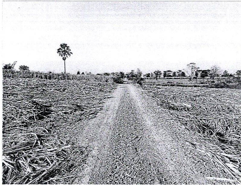
รูปถนนหินคลุก บ้านดงลาน หมู่ที่ ๙ ตำบลดงลาน - ตำบลบริบูรณ์ อำเภอสว่างแดนดิน จังหวัดหนองบัวลำภู
